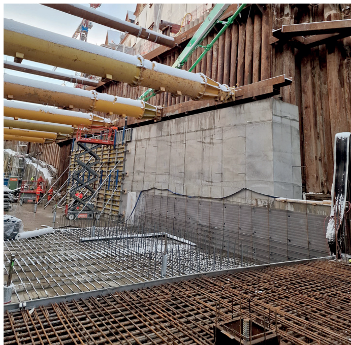
Figur 1: Massiva konstruktionselement, järnvägstunnel Varberg. Temperatursprickor har undvikits med kylning dimensionerad genom sprickriskberäkningar för klimatförbättrad betong nivå 2.
